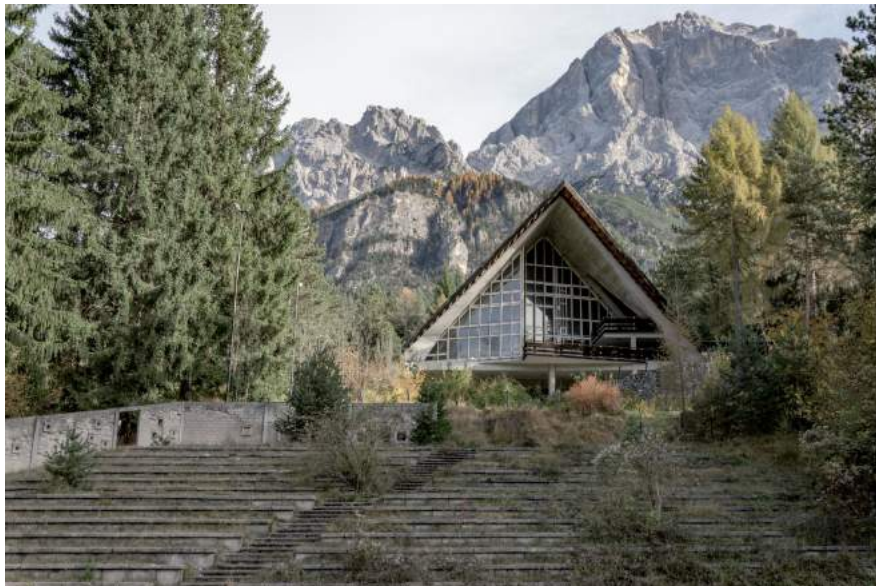
Il padiglione centrale della Colonia sovrastato dall'Antelao, vista dal Piazzale delle Adunate, foto di Nicola Noro, ottobre 2016.
